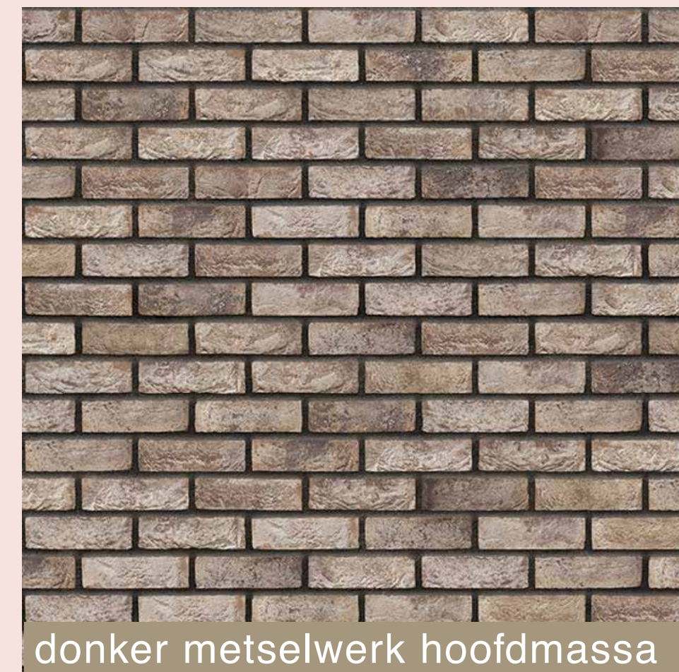
donker metselwerk hoofdmassa
